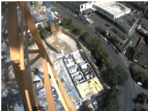
Abbildung 4: Nullmessung am 30.06.2022: nach Herstellung der Bodenplatte
